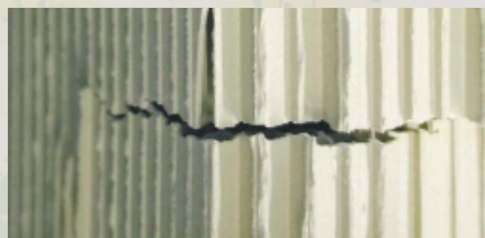
Abb.4: Freigelegte, ca. \varnothing 40 mm grosse Materialtrennung (Herstellungsfehler) quer zur Extrusionsrichtung.
