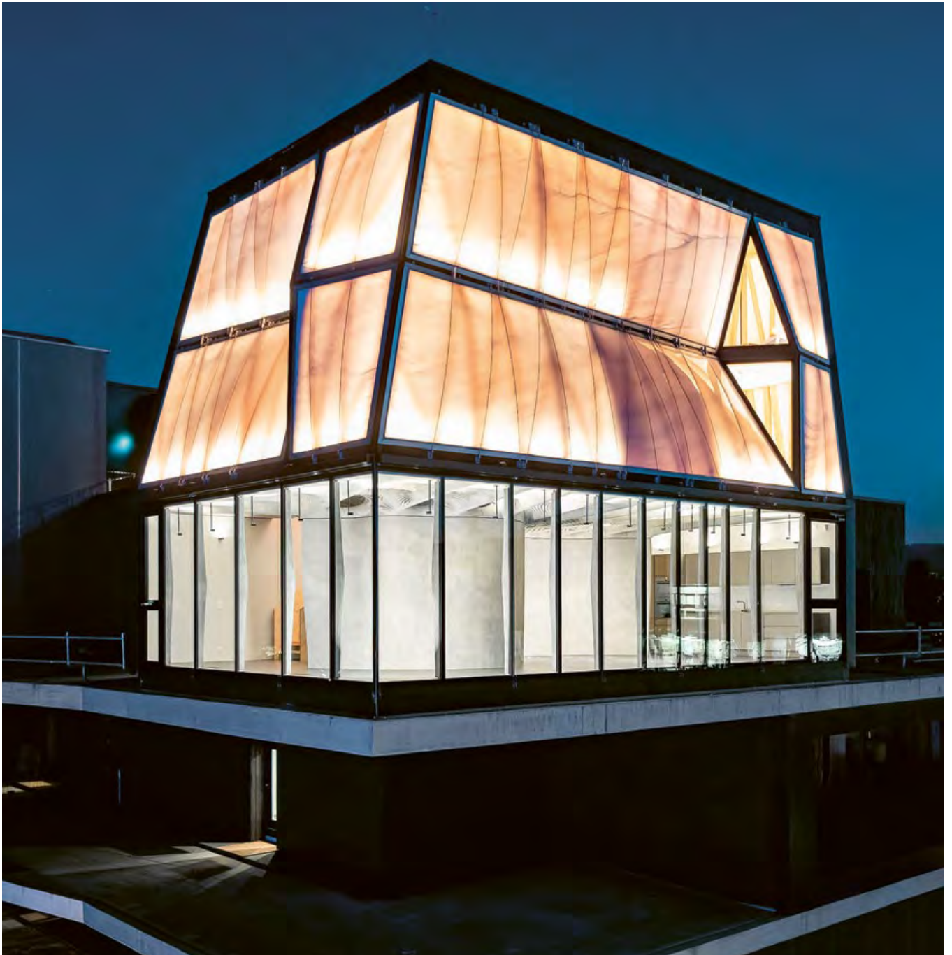
La nouvelle unité «DFAB HOUSE» de NEST. Image: Roman Keller
