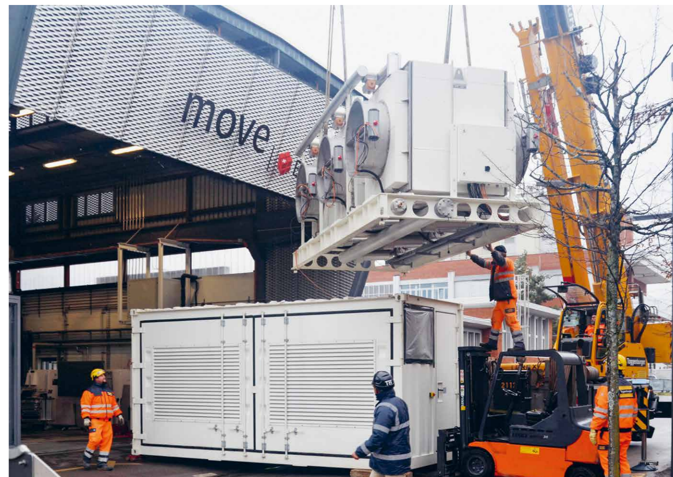
Livraison exceptionnelle: le démonstrateur de mobilité «move» de l'Empa a reçu en novembre 2021 un système «Direct-Air-Capturing» de Climeworks. L'installation permettra d'extraire du CO 2 de l'atmosphère, lequel sera utilisé dans la synthèse de méthane.
