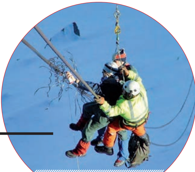
Riss am Seil der Schilthornbahn
