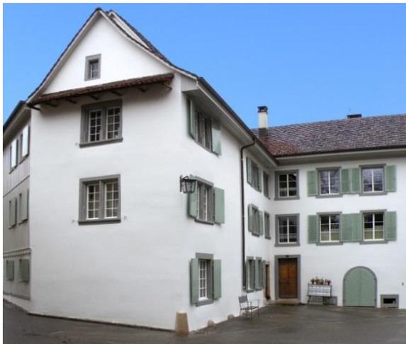
Mehr als 5000 m<sup>2</sup> Aerogelputz wurden in der Schweiz bereits auf Fassaden aufgebracht. Eines von bisher 35 gedämmten Objekten ist diese denkmalgeschützte Mühle in Sissach, BL.
