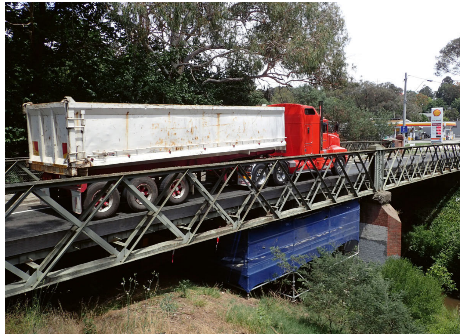
Die Diamond Creek Bridge nahe Melbourne wurde 2018 mit CFK-Streifen verstärkt und nach getaner Arbeit ihre Haltbarkeit mit einem 42-Tonnen-Truck getestet.
