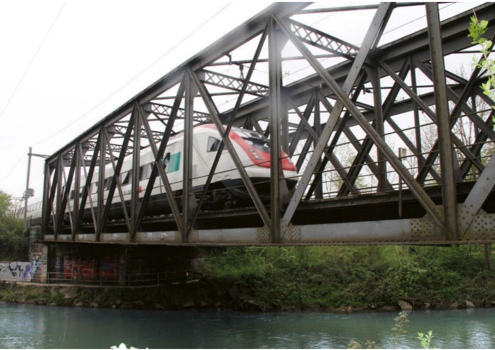
Die Münchensteinbrücke nahe Basel ist seit 2015 mit CFK-Streifen verstärkt. Mehrere Intercity-Züge pro Stunde und mehrere Güterzüge pro Tag rollen über die 126 Jahre alte Brücke.
