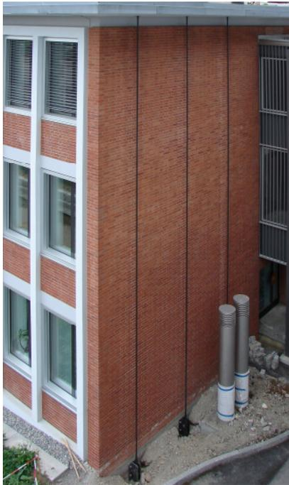
Montage de câbles en CFC installés sur la façade du bâtiment administratif de l'Empa en 2008 pour son renforcement antisismique.
