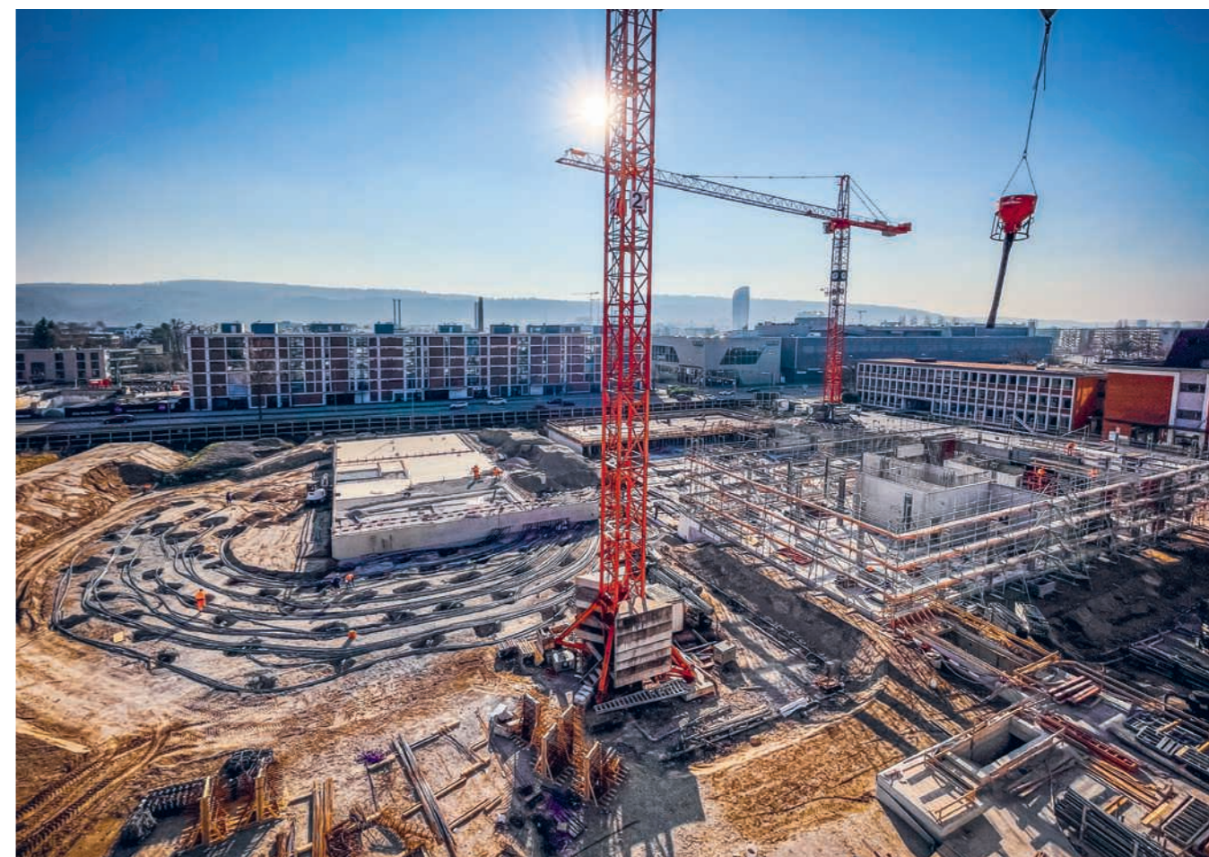
Vue du chantier de l'extension du campus co-operate, sous le bâtiment duquel est construit un champ de sondes géothermiques avec 144 sondes géothermiques allant jusqu'à 100 mètres de profondeur (à gauche sur la photo).
