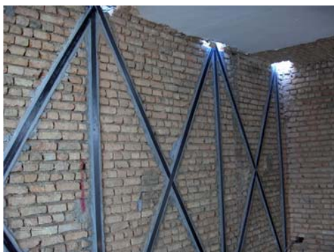
Maçonnerie renforcée par collage de lamelles de PRC.
