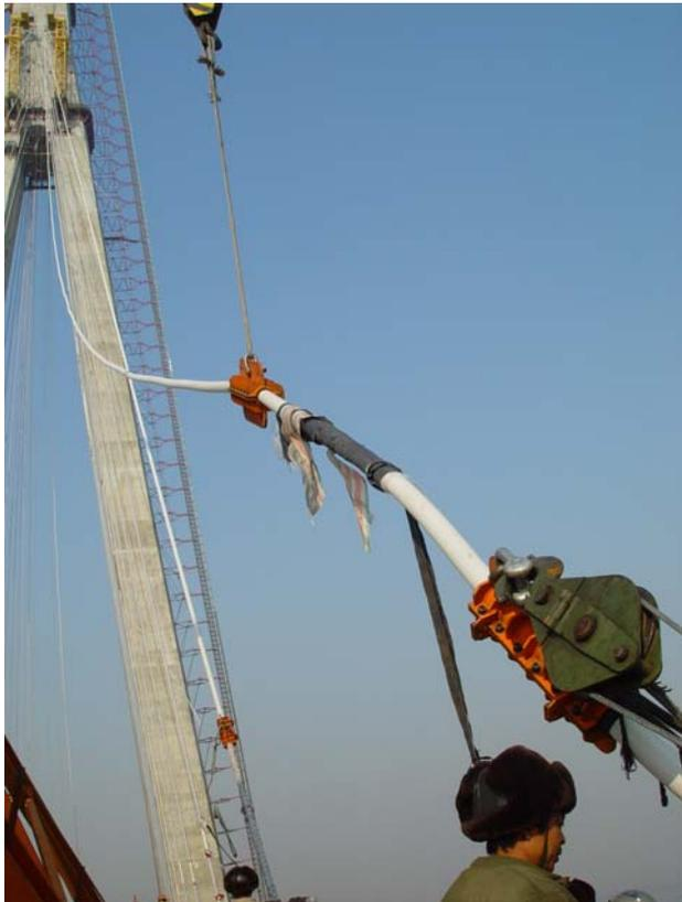
Montage du dixième câble de 228 mètres du pont de Sutong sur le Yangtse.
